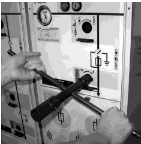
2. Đóng cầu dao tiếp địa bằng cách quay tay cầm điều khiển theo chiều kim đồng hồ
