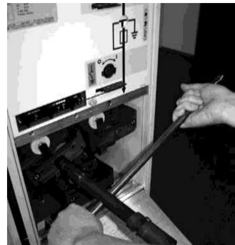
5. Sử dụng tay cầm điều khiển và quay tay cầm điều khiển ngược chiều kim đồng hồ để mở hộp đựng cầu chì
